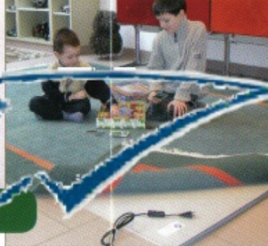
Heizfilmverlegung unter vorhandenem Teppich
